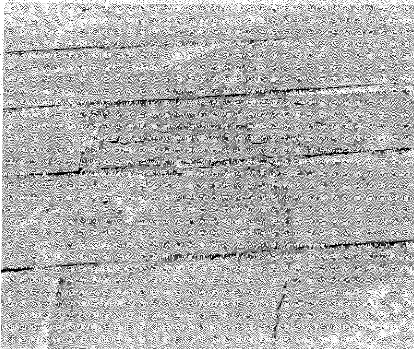
Fig. 10. Détail de la photo précédente montrant l'exfoliation des briques en terre cuite causée par la pression de cristallisation du sulfate de sodium.
